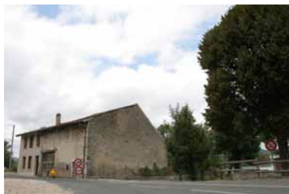
bâtiment existant pouvant accueillir un restaurant
