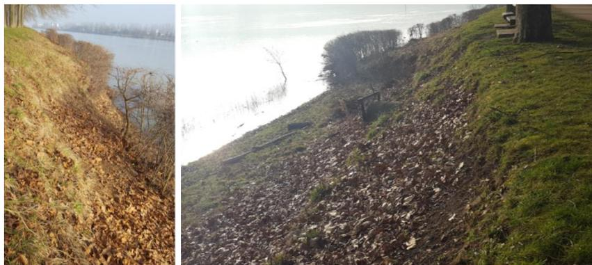
**Fig. 5. Traces d'érosion au droit de la zone pressentie pour l'implantation d'appontements**
