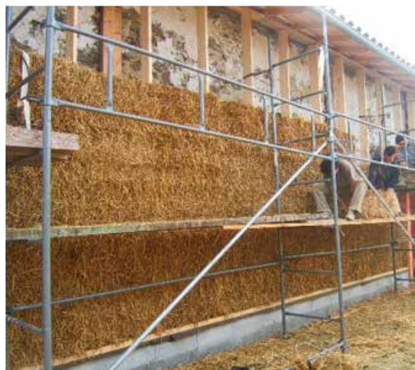
Isolation extérieure en paille
