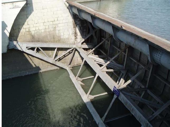
Vanne et clapet de surface
