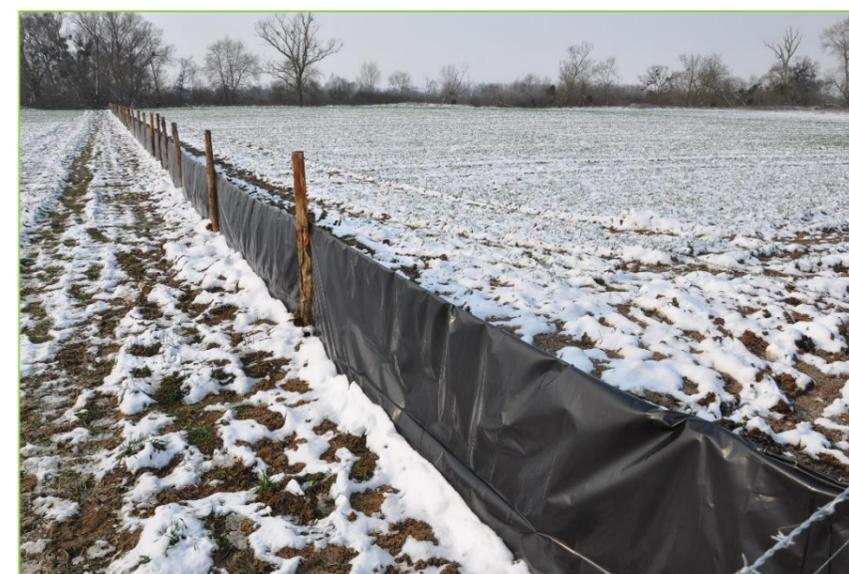
Photographie 5 - Exemple de clôture imperméable à la faune (Source : ECO-STRATEGIE)
