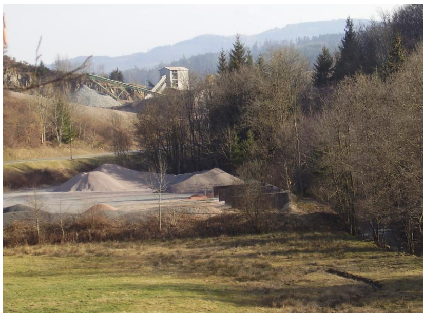
Stockage des granulats- Carrière de Saint-Just-en-Chevalet
