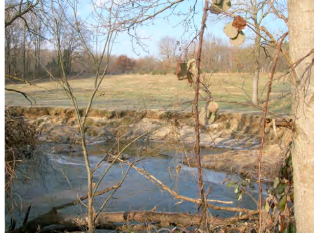
Érosion sur le Vizézy vers les Vaccants
