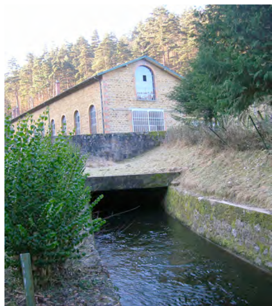
Usine hydroélectrique de Saint Martin - Saint Georges en Couzan
