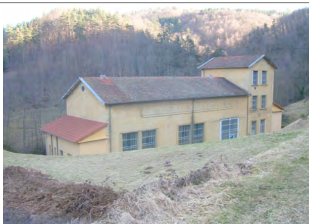
Usine hydroélectrique de Rory – Saint Georges-en-Couzan
