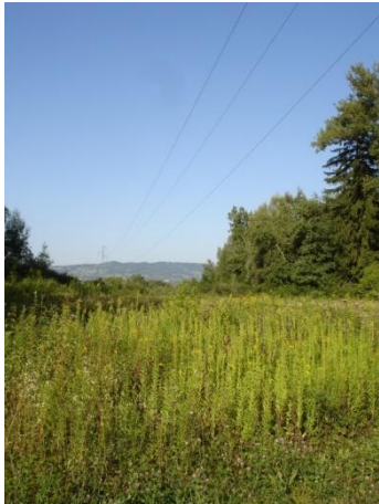
Figure 11 : un dessous de ligne électrique sur le site, envahit par le Solidage
