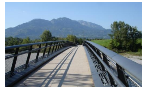
Figure 14 : la passerelle entre Saint Pierre en Faucigny et Bonneville
