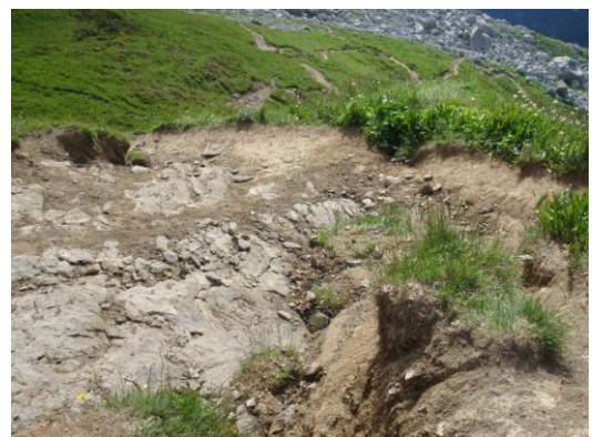
Figure 25 : dégradations visibles sur le sentier menant au lac de Peyre
