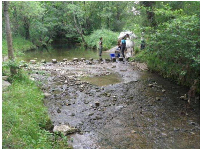
Figure 43 : CLA2 - Faible hauteur d'eau sur le radier
