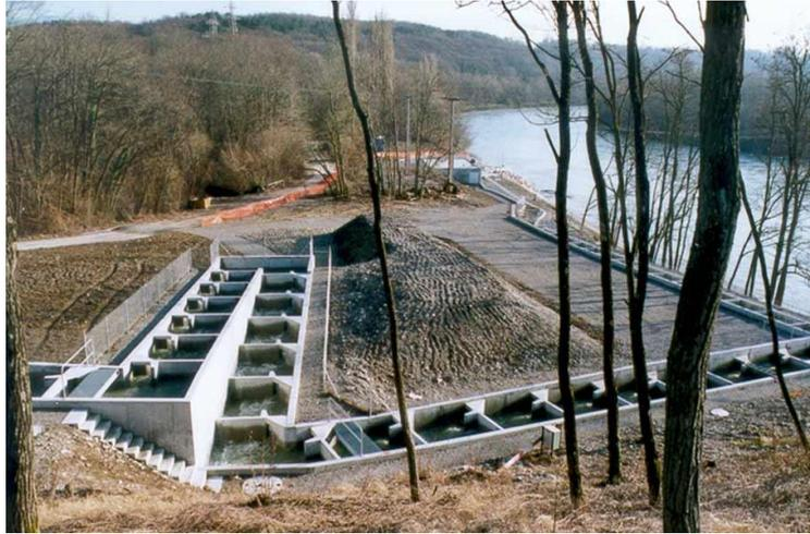
Figure 31 : Passe à poissons au barrage de Verbois, 320 m pour 107 bassins. Conçu en 2000 (Ingerop)
