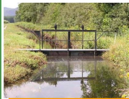
Vanne sur le fossé Tramont. Photo RNML
