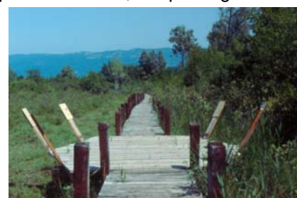
Le sentier sur pilotis est équipé de panneaux pédagogiques. Photo RNML
