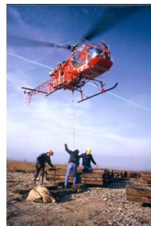
La construction du pilotis a nécessité des moyens importants. Photo RNML
