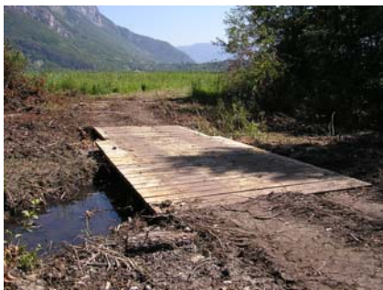
Un pont sur fossé, pour faciliter l'accès aux prairies. Photo RNML
