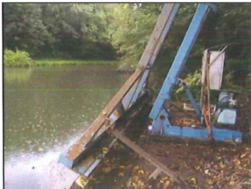
**Dégrilleur et prise d'eau sur la retenue, en rive gauche de la Fure (amont immédiat du barrage)**
