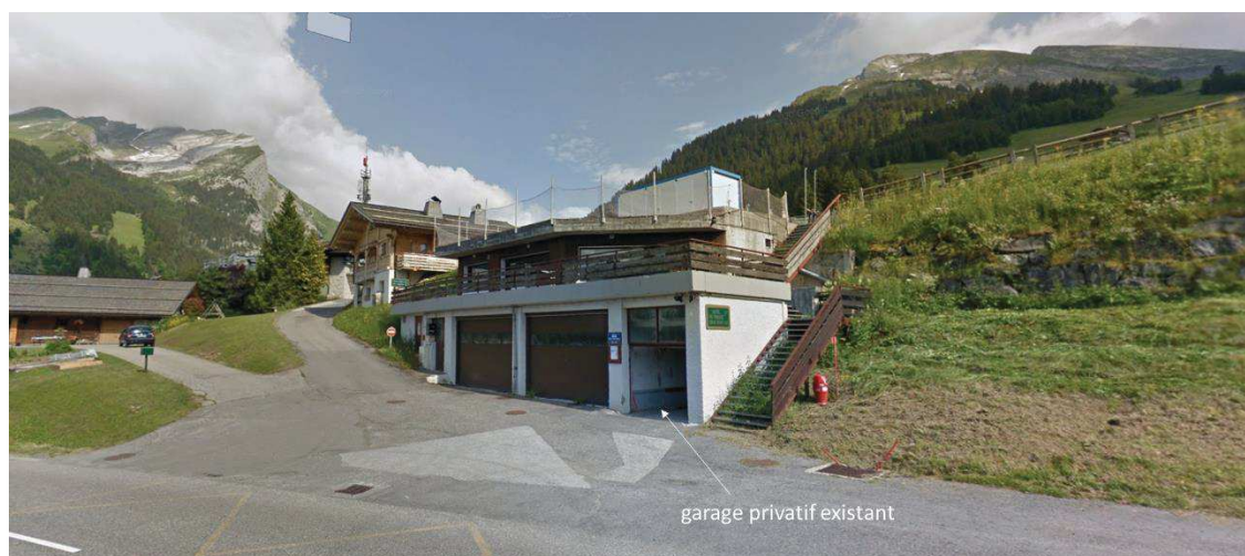
Le bâtiment concerné
