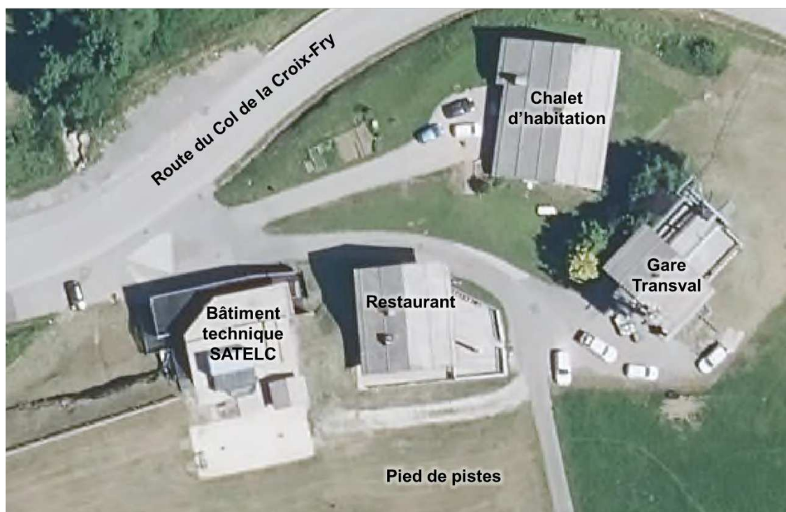
Localisation du bâtiment technique de la SATELC concerné par le projet
