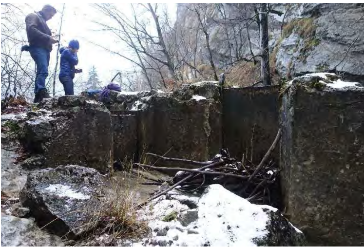
Vannages en place, posés sur dalle rocheuse importante
