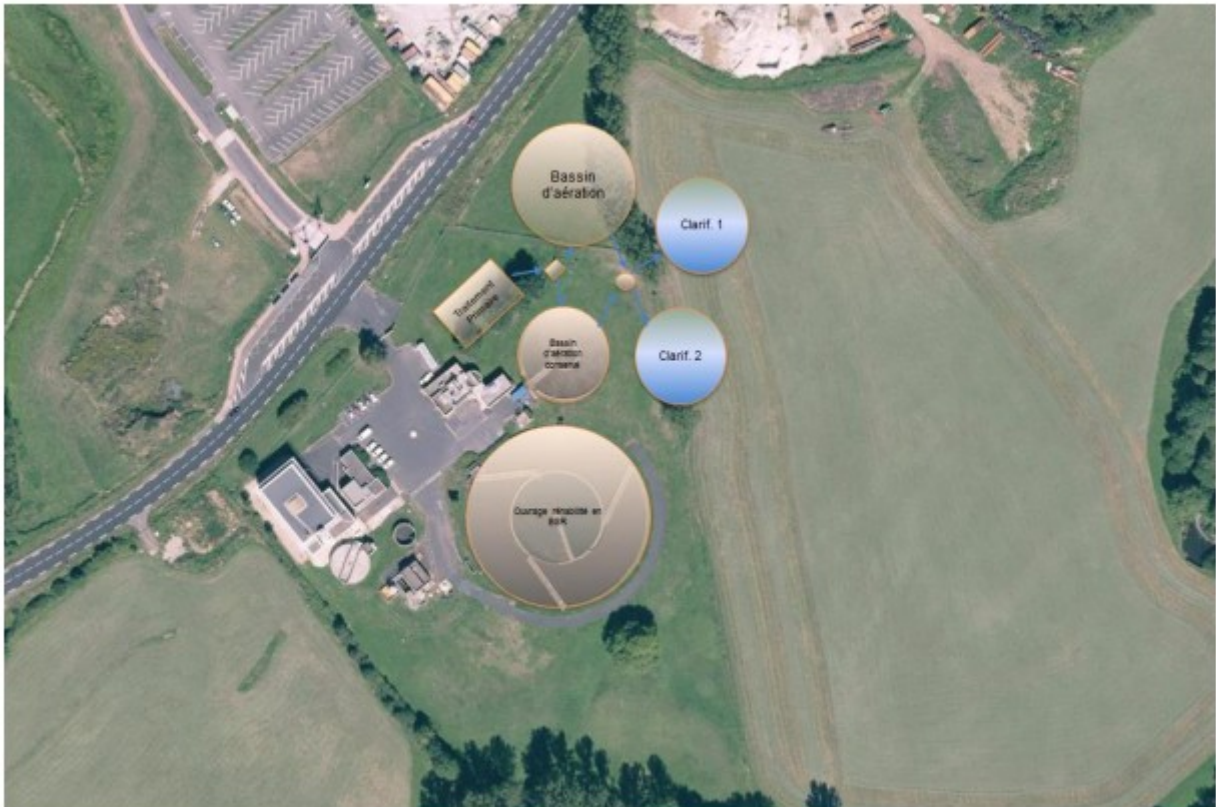
Pré-implantation des ouvrages sur le site de Souleyrie
