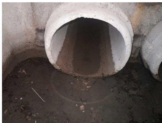
Arrivée des conduites busant le fossé
