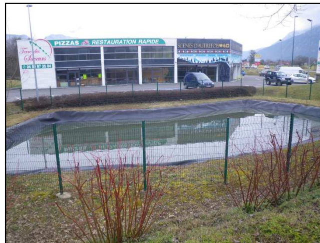
Bassin de rétention à ciel ouvert sur le secteur de Vozerier
