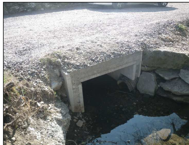
Cadre béton réalisé
