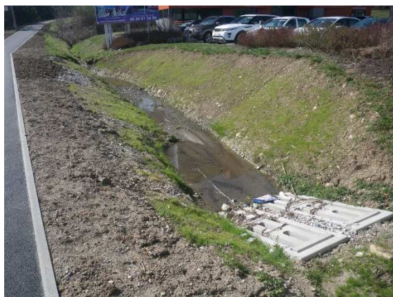
Re-calibrage et entonnement du fossé
