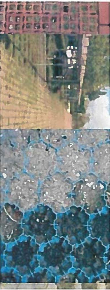
Représentations : pavés enherbés, pavés non jointés, dalles alvéolées enherbées, gravillons, stabilisé enherbé
