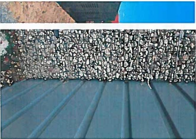
Exemple de jeux de matériaux, habillage de gabion et bardage métallique.
