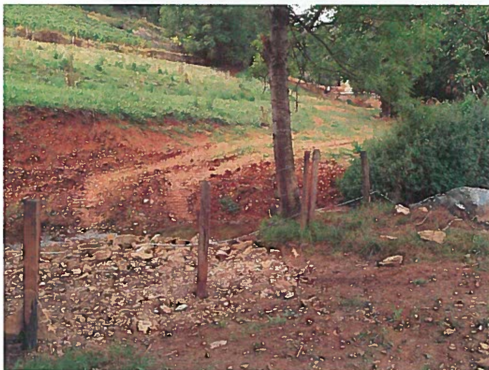
Photo N° 1 : prise de vue 24-08-2010 – zone de raccordement aval de la première zone de dévoiement
