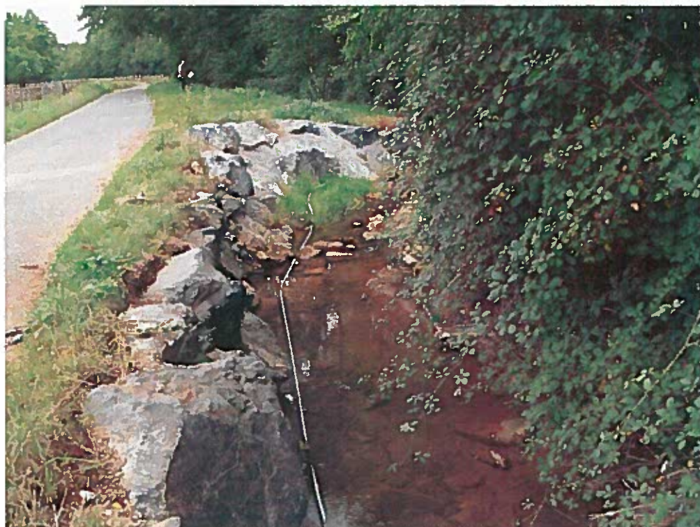
Photo N° 3 : prise de vue 24-08-2010 protection de berge bord de route
