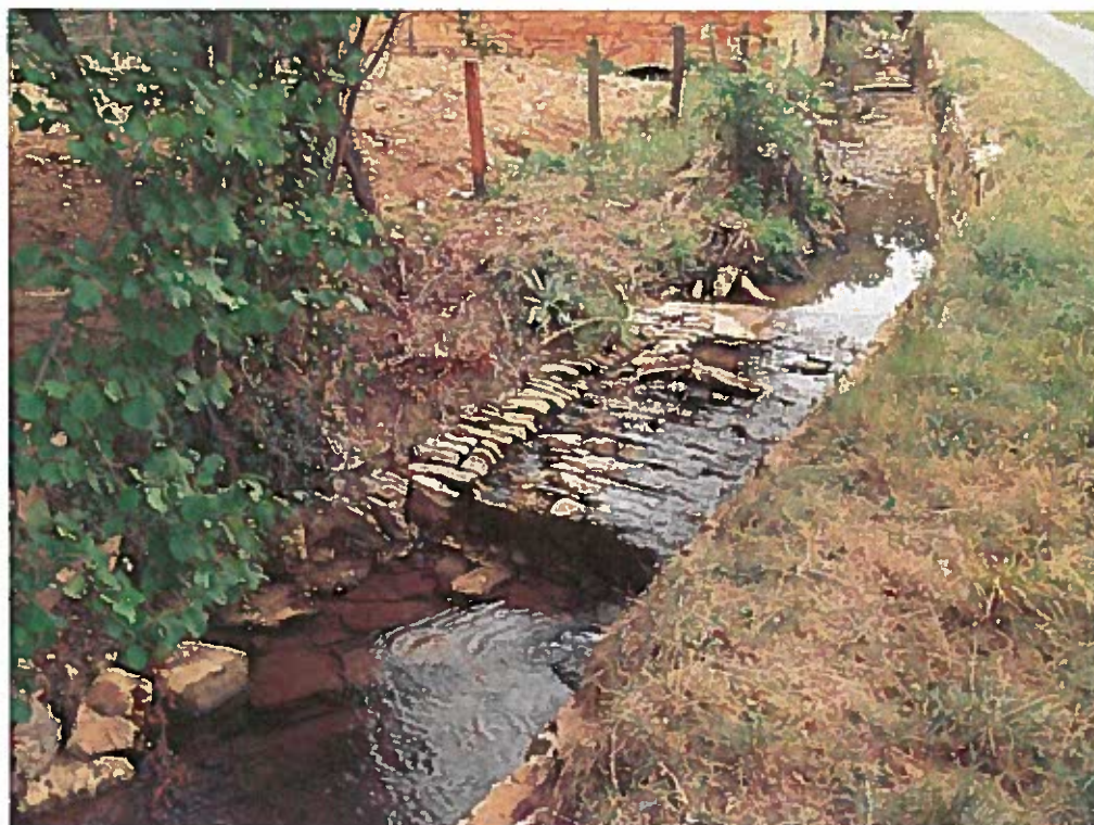
Photo N° 2 : prise de vue 24-08-2010 - ouvrage amont à aménager
