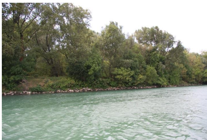
Cliché 7 – Vue de la digue démantelée, 2016
