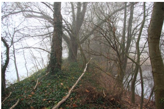
Cliché 1 – Vue de la digue démantelée (vue vers l'aval), 2016
