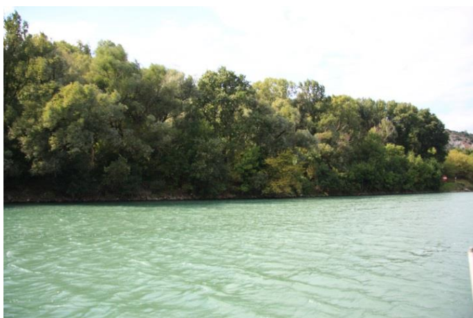
Cliché 5 – Digue où seront créées les deux brèches amont, 2016
