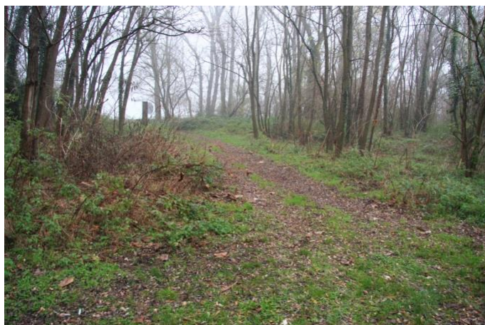
Cliché 4 – Emplacement des brèches et du recreusement du chenal amont (vue vers l'aval), 2016
