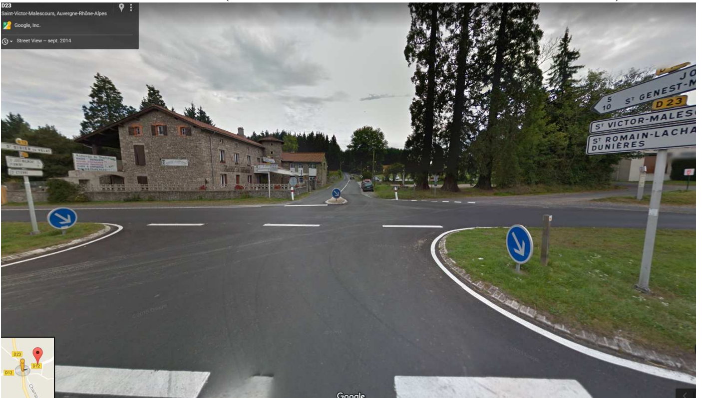
Prise de vue au PR1+909 (Vue aval - RD12 coté Saint-Genest-Malifaux)
