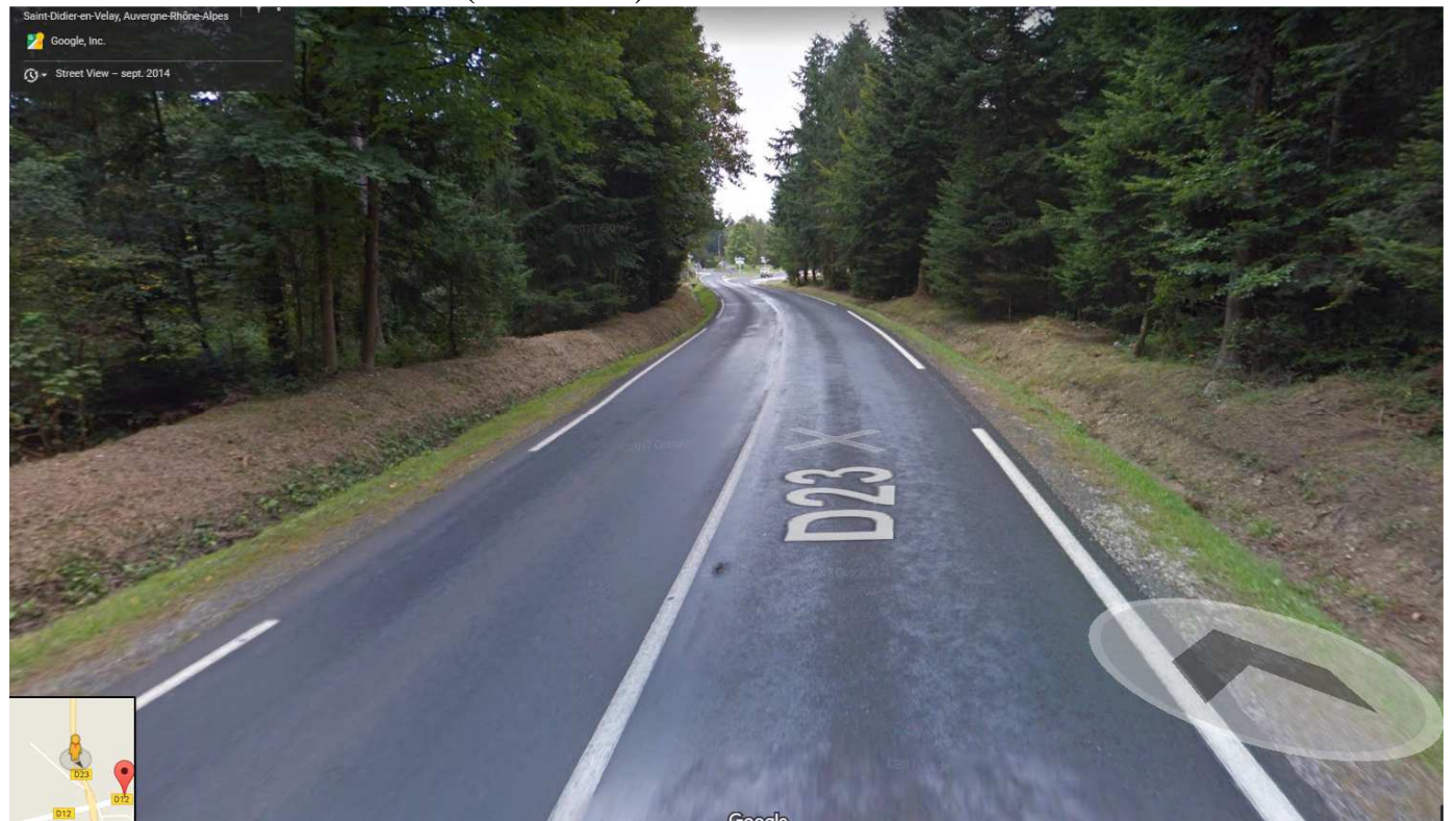
Prise de vue au PR1+725 (Vue aval)
