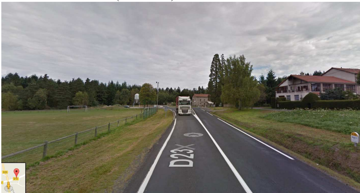
Prise de vue au PR2+000 (Vue Amont)
