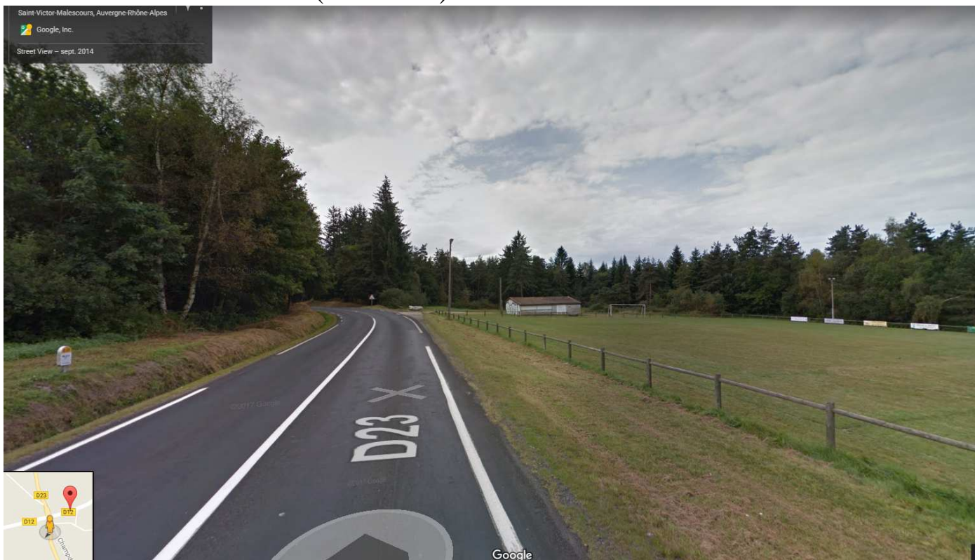
Prise de vue au PR2+000 (Vue Aval)
