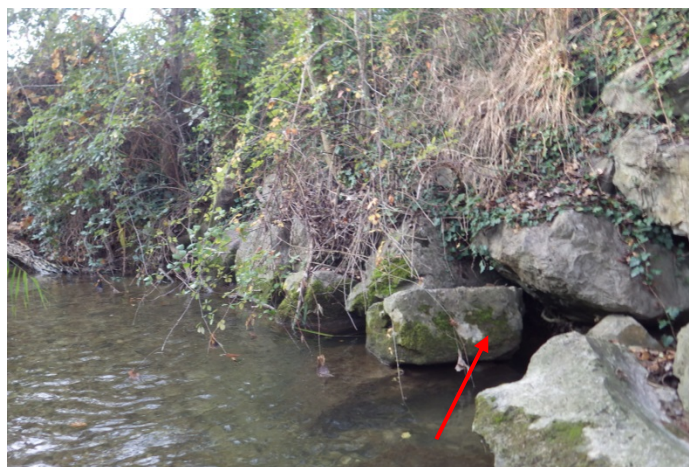
Blocs déstabilisés entre PL1 et PL2/3
