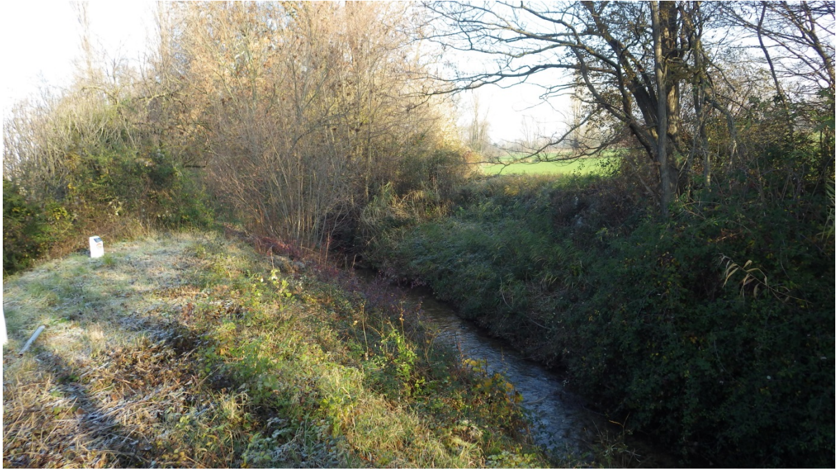
P2 : Vue du cours d'eau (vers l'aval) au droit du franchissement des canalisations PL2/PL3
