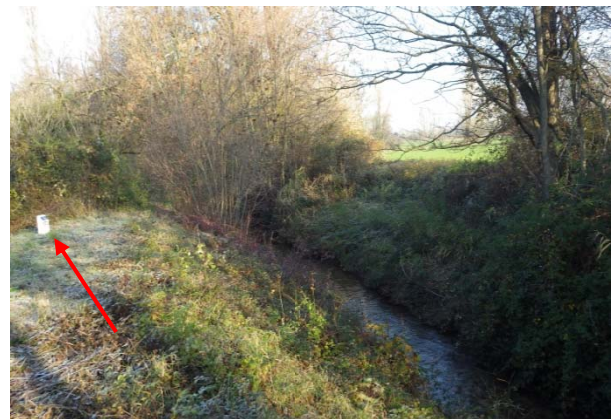
Vue générale vers l'aval au franchissement PL2/3 (la flèche indique la borne repère SPSE)
