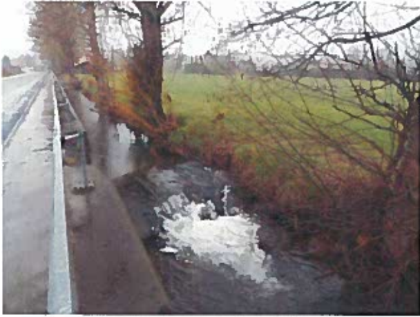
Seuil en bordure de la RD19
