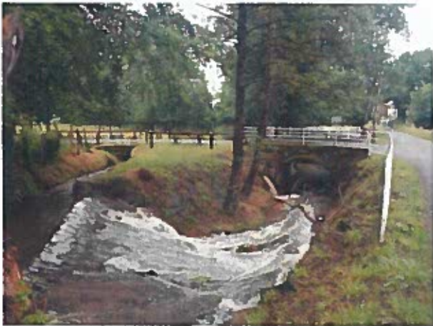
Chaussée de La Peyrade et pont de la route communale en aval immédiat (effacement du seuil programmé et reprise de l'ouvrage routier)
