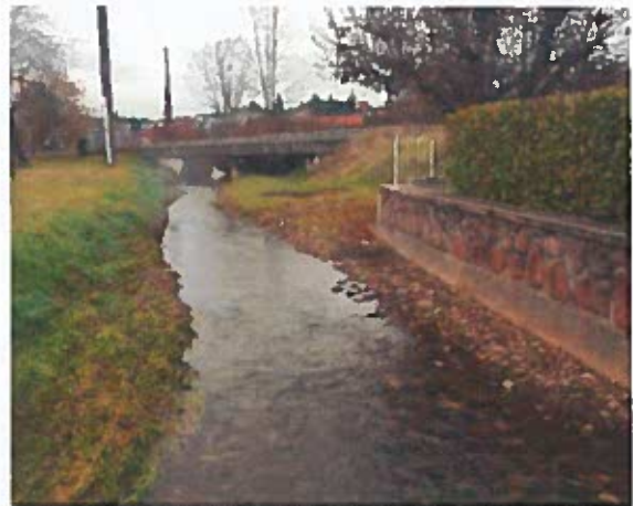
Lit principal de l'Arcambe en aval de la voie ferrée
