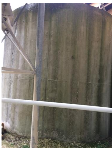
Figure 26 : Silo anciennement utilisé pour le stockage des boues avant passage à la centrifugeuse
