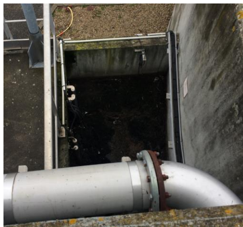
Figure 20 : Puits des pompes de recirculation
