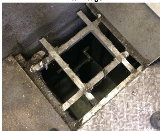
Figure 16 : Trop plein en sortie des tamis rotatifs
