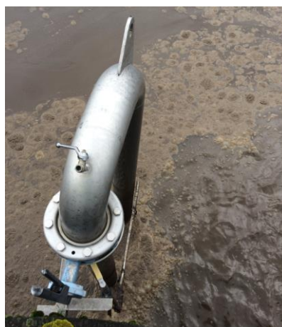
Figure 21 : Aération du bassin
