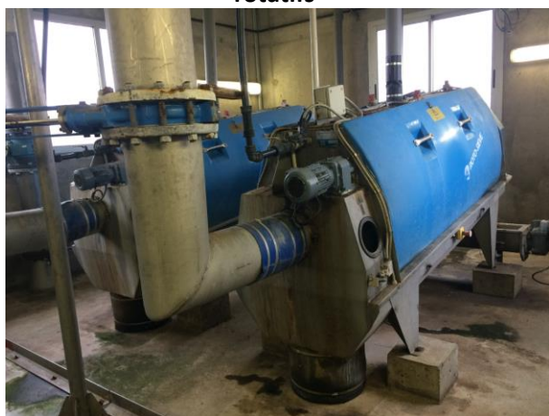
Figure 13 : Deux tamis rotatifs fonctionnant en parallèle
