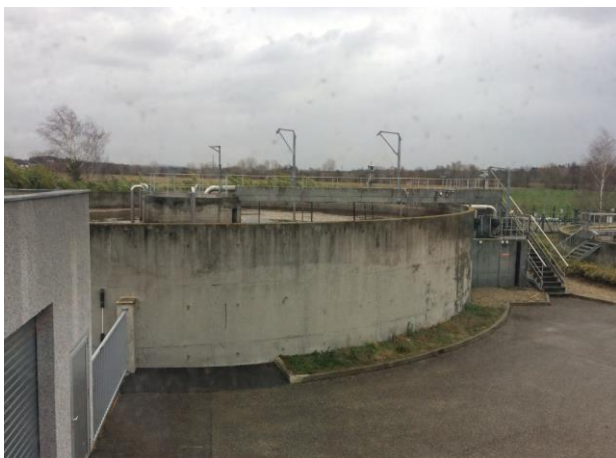
Figure 17 : Bassin d'aération avec zone de contact au centre
