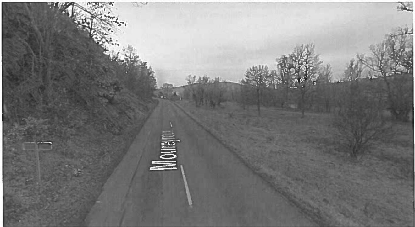
Fin du lieu-dit Pont de Costet Vers P13
