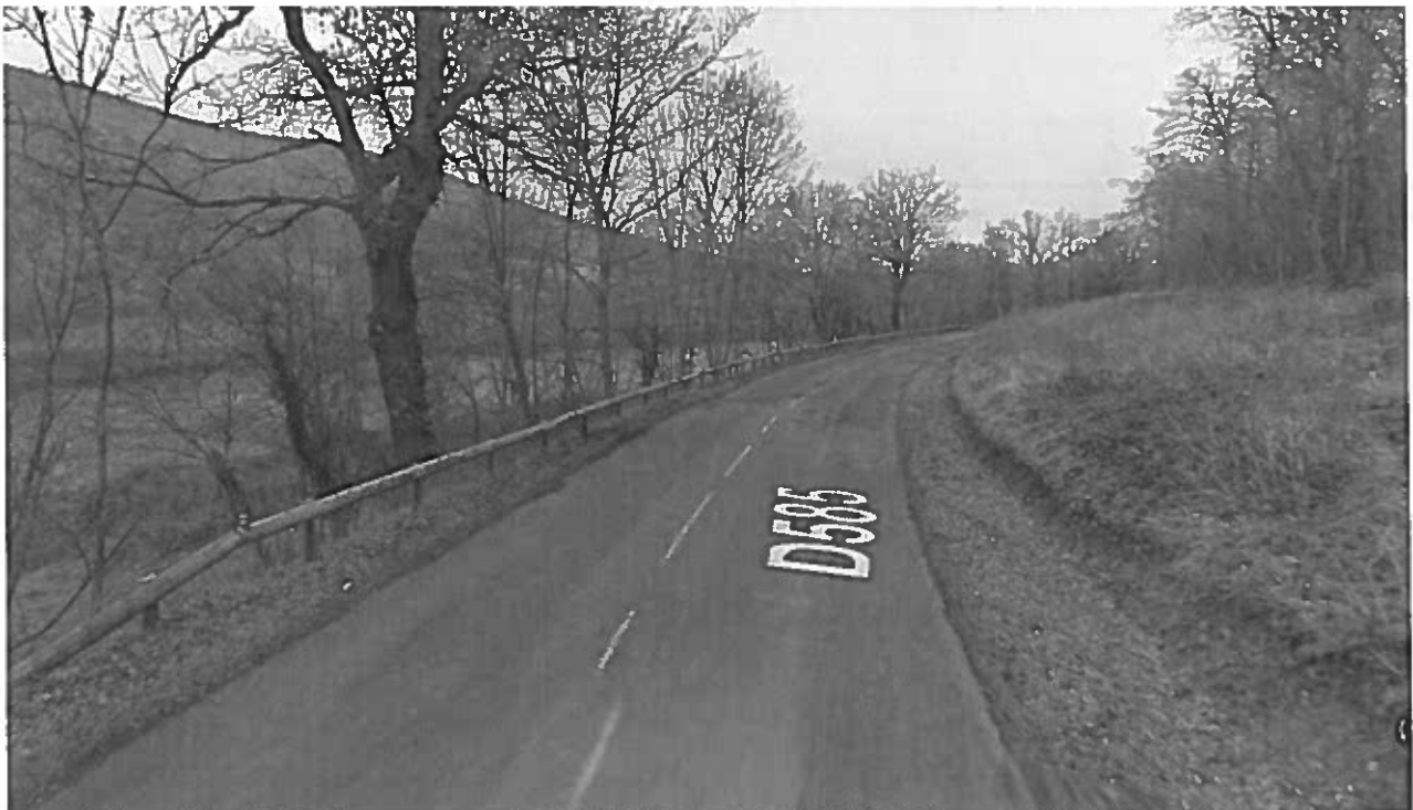
Fin du lieu-dit Pont de Costet Vers P34
