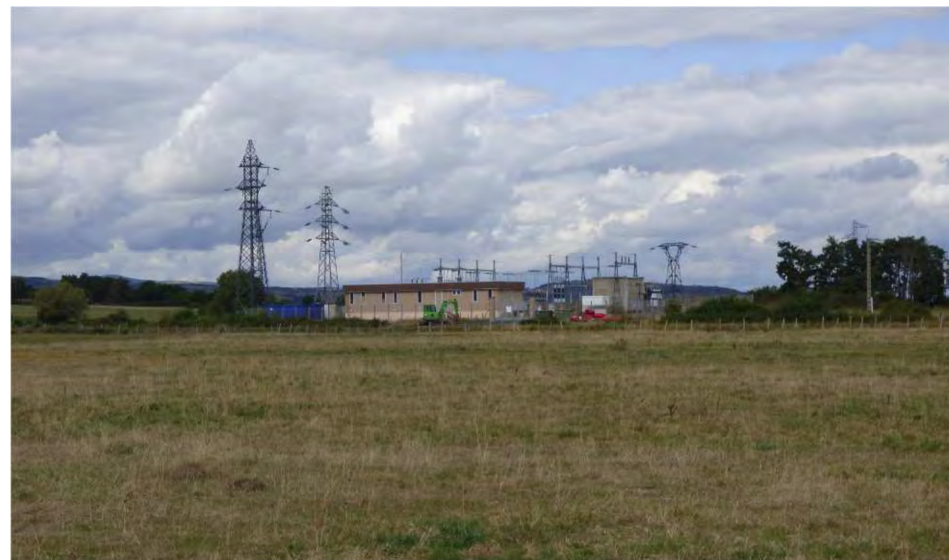
Les terrains du projet
