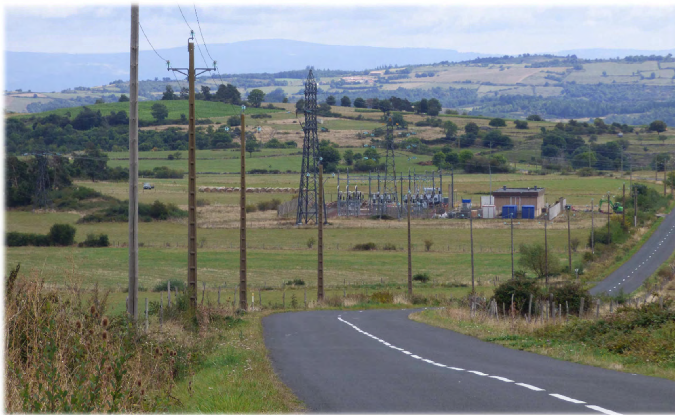
Perception sur l'aire d'étude depuis la RD21 à l'ouest du site : les lignes électriques marquent largement les perceptions. Le poste existant concentre les pylônes.
