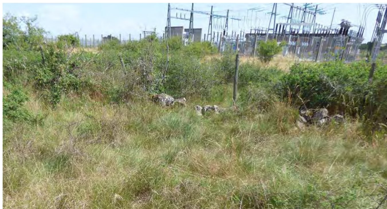
Terrains étudiés pour l'implantation potentielle du poste
