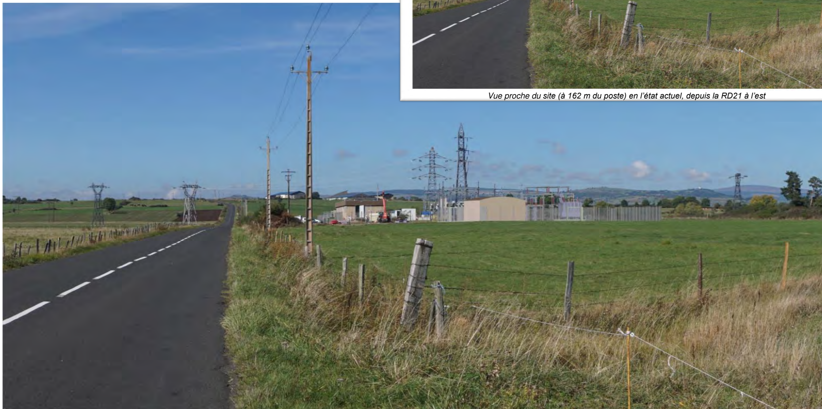
Vue proche du projet depuis la RD21 à l'est
