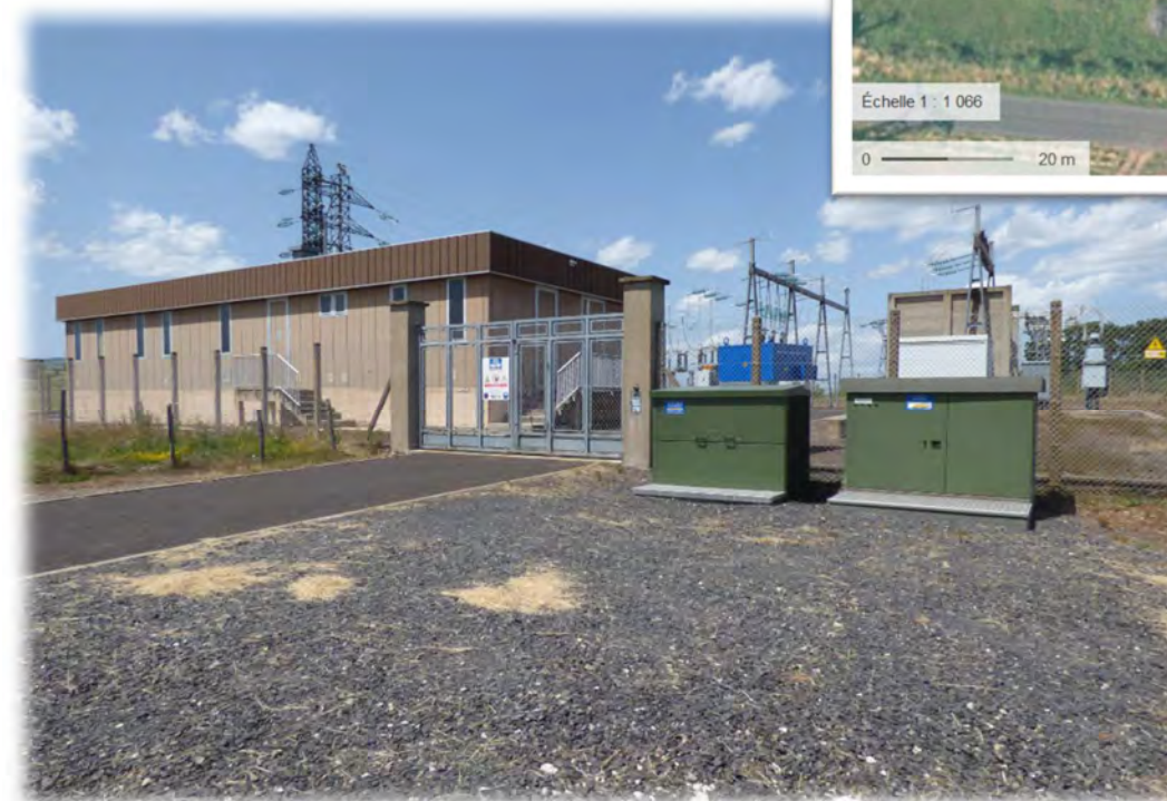
Poste de transformation existant au sein de l'AEI
