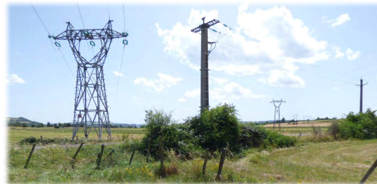
Lignes électriques aériennes passant au sein de l'AEI
