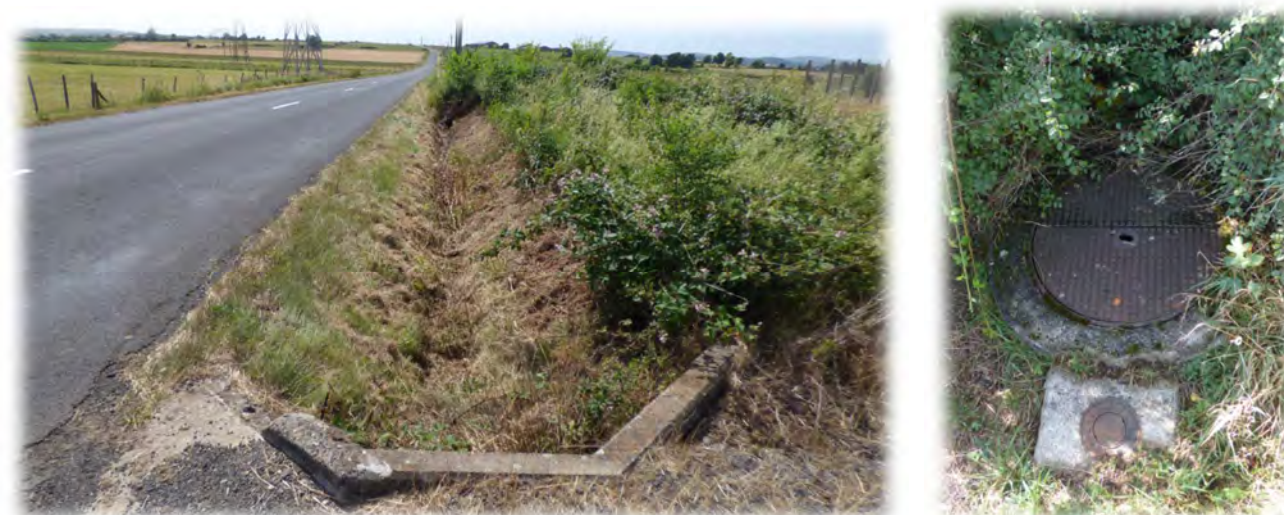
Fossé de gestion des eaux de pluie et regard du SIAEP au droit du site le long de la RD21
