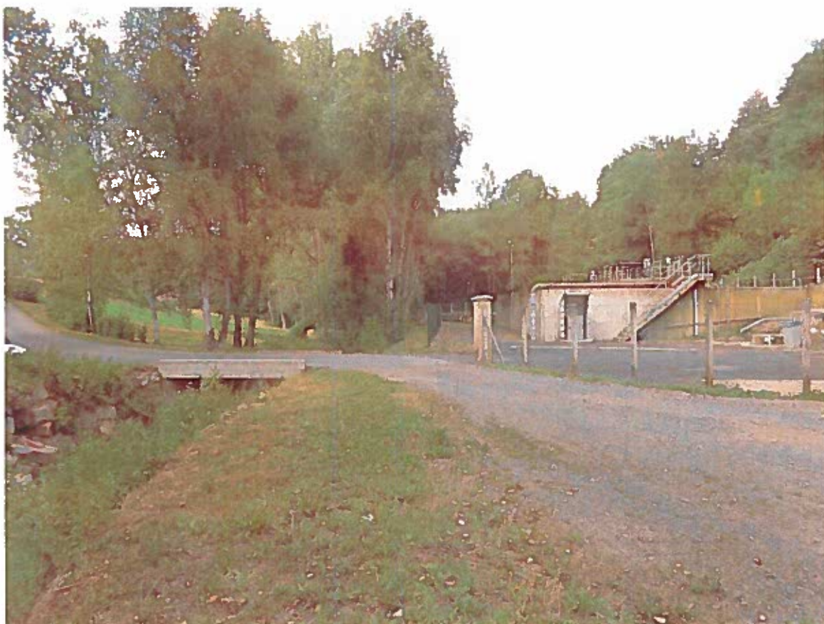
PHOTO N°6 - Vue de la station actuelle en rive droite du ruisseau du Crisselle – Juillet 2017
