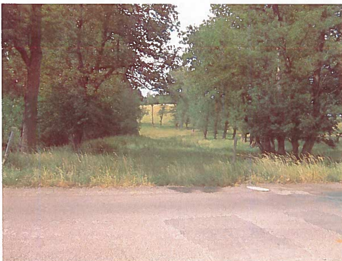
PHOTO N°10 - Vue du réseau de transfert des eaux usées après le dessableur – Juin 2015
