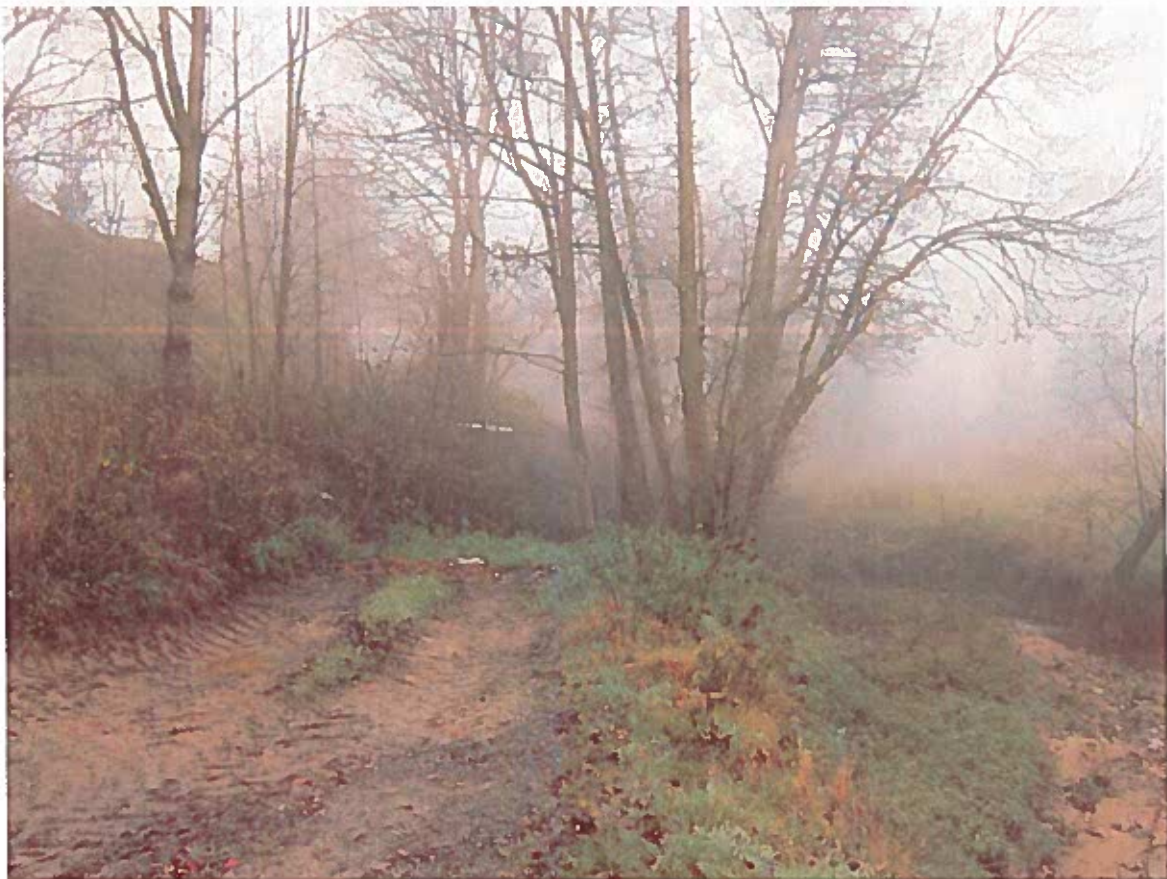
PHOTO N°9 - Vue de l'arrivée du réseau d'eaux usées avec le déversoir d'orage actuel – Décembre 2017
