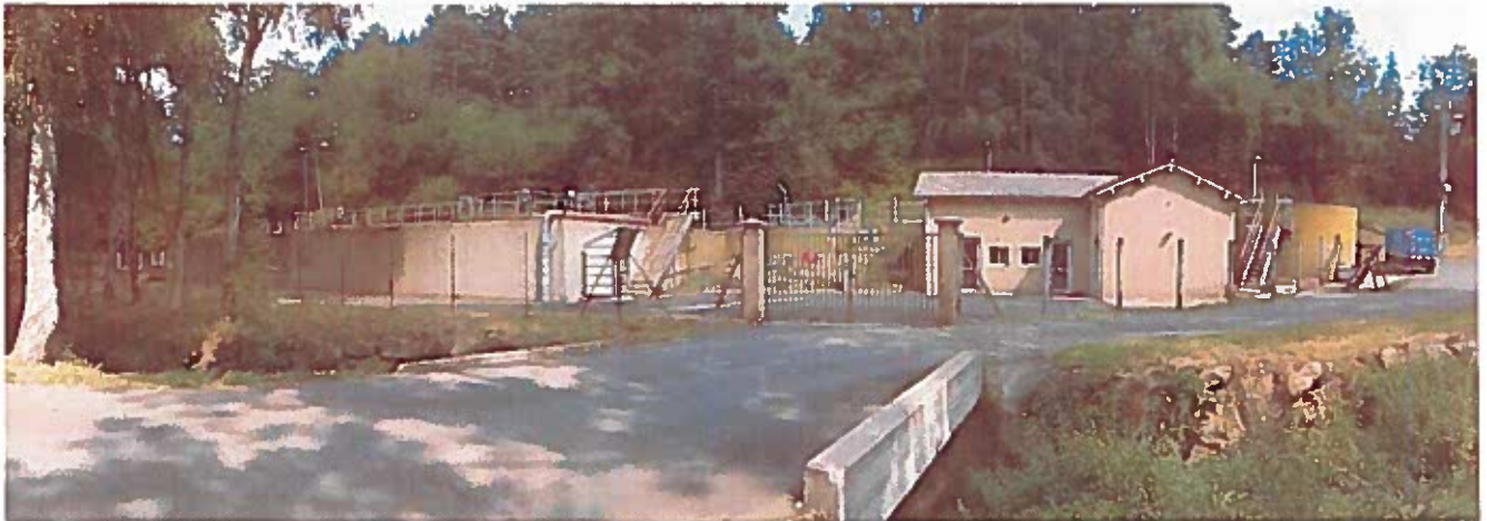
PHOTO N°8 - Vue générale de la station actuelle depuis le chemin d'accès – Juillet 2017
