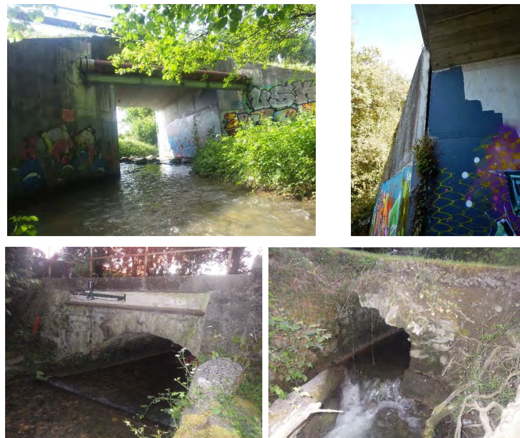
Illustration 9 : En haut, pont et disjointement du Pamphiot sur la RD903 ; en bas, ouvrages au niveau de la rue du Moulin non favorable aux chiroptères en gîte
