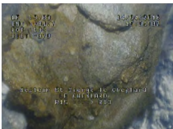
Casse (effondrement sur la canalisation)
