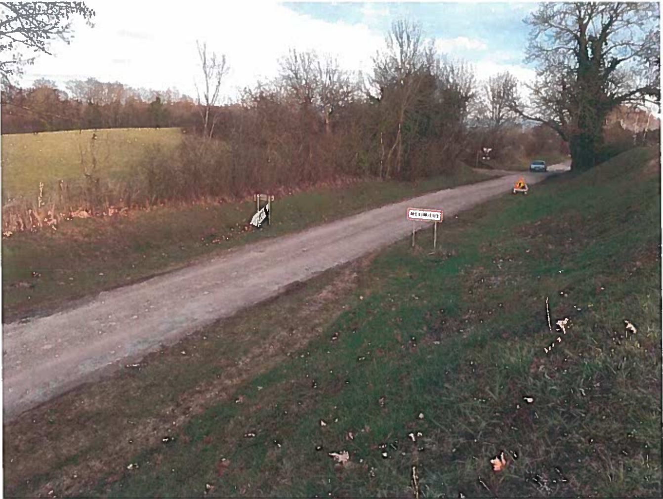
Photo 3 : Vue depuis l'aire de repos de la RD22a vers l'Est – 8 Mars 2018
