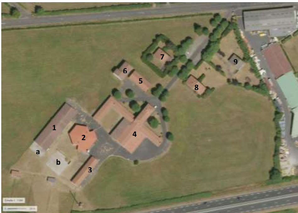
Repérage des bâtiments à déconstruire
