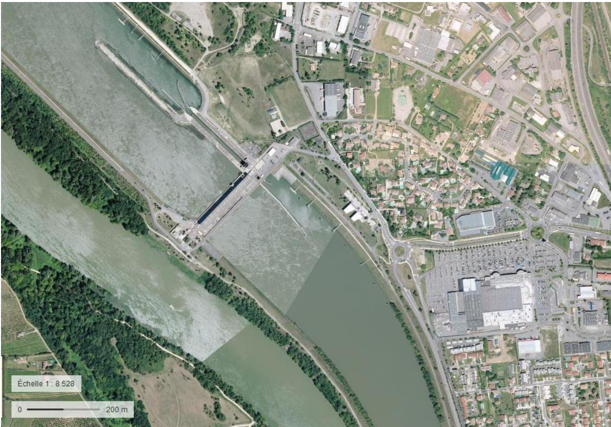
Figure 11 : Photographie aérienne de la centrale © Geoportail
