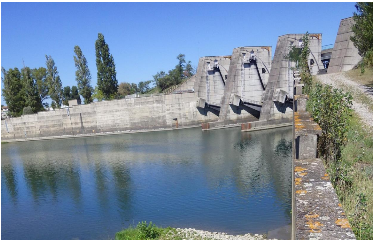
Figure 13 : Barrage de l'Isère photographié depuis la rive gauche aval
