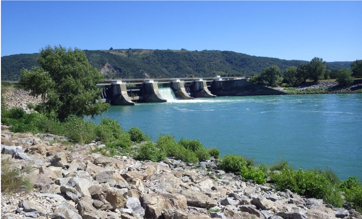
Figure 19 : Photographie du barrage depuis la rive droite aval
