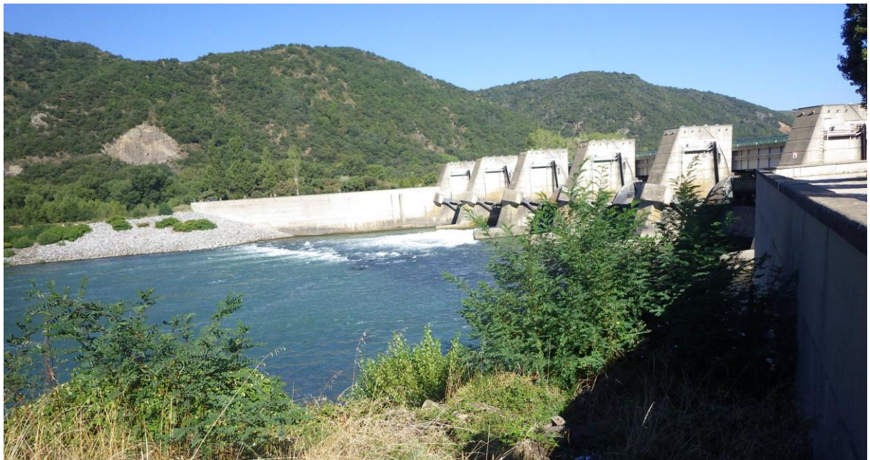
Figure 15 : Photographie du barrage depuis la rive gauche aval
