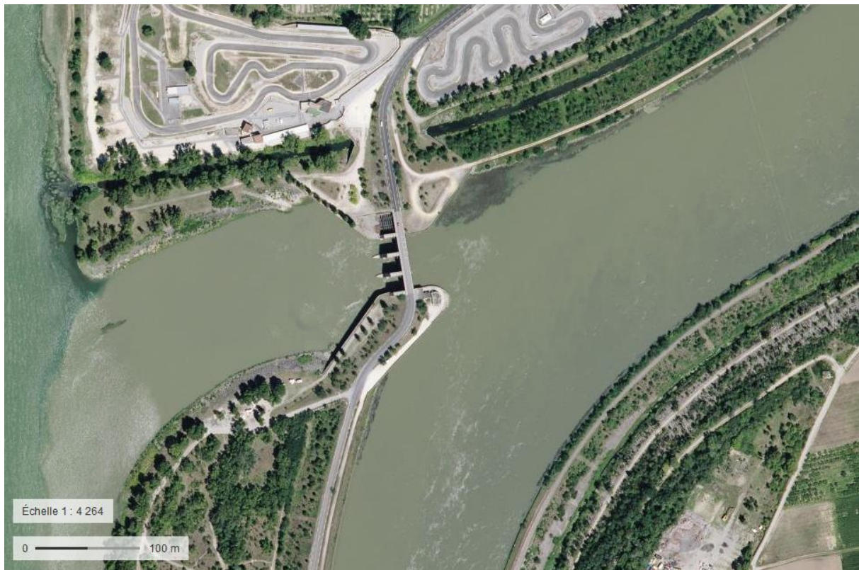
Figure 12 : Photographie aérienne du barrage de l'Isère © Geoportail
