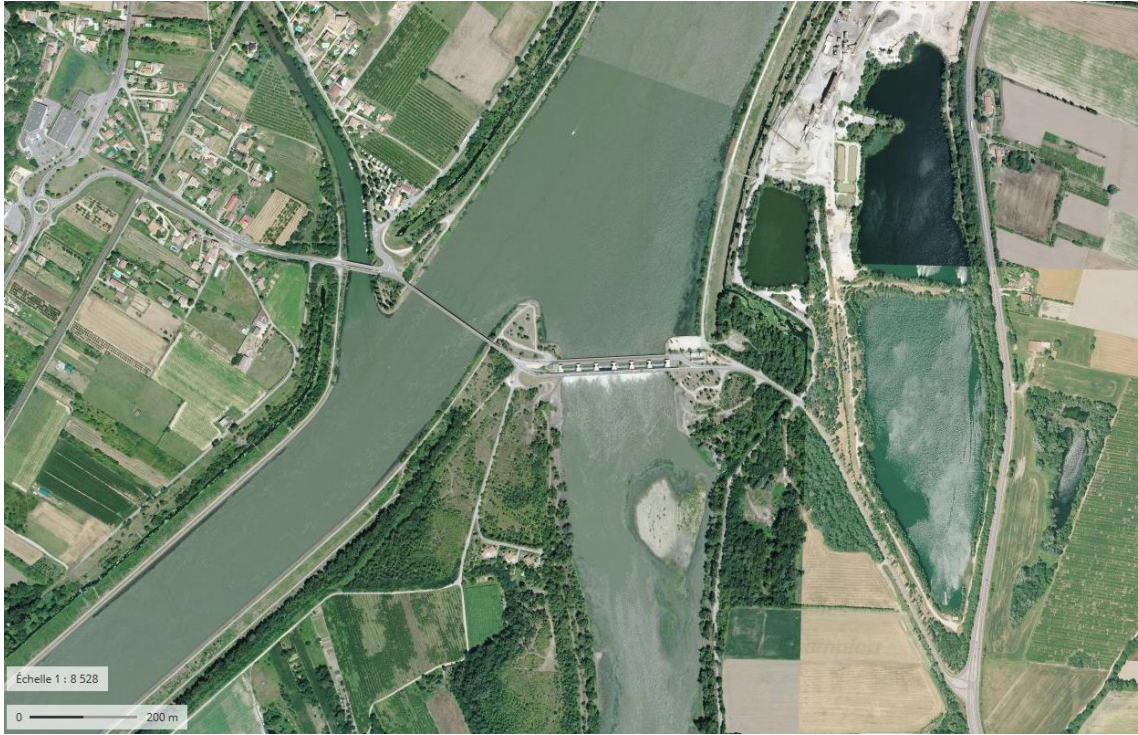
Figure 7 : Photographie aérienne du barrage de Charmes-sur-Rhône © Geoportail
