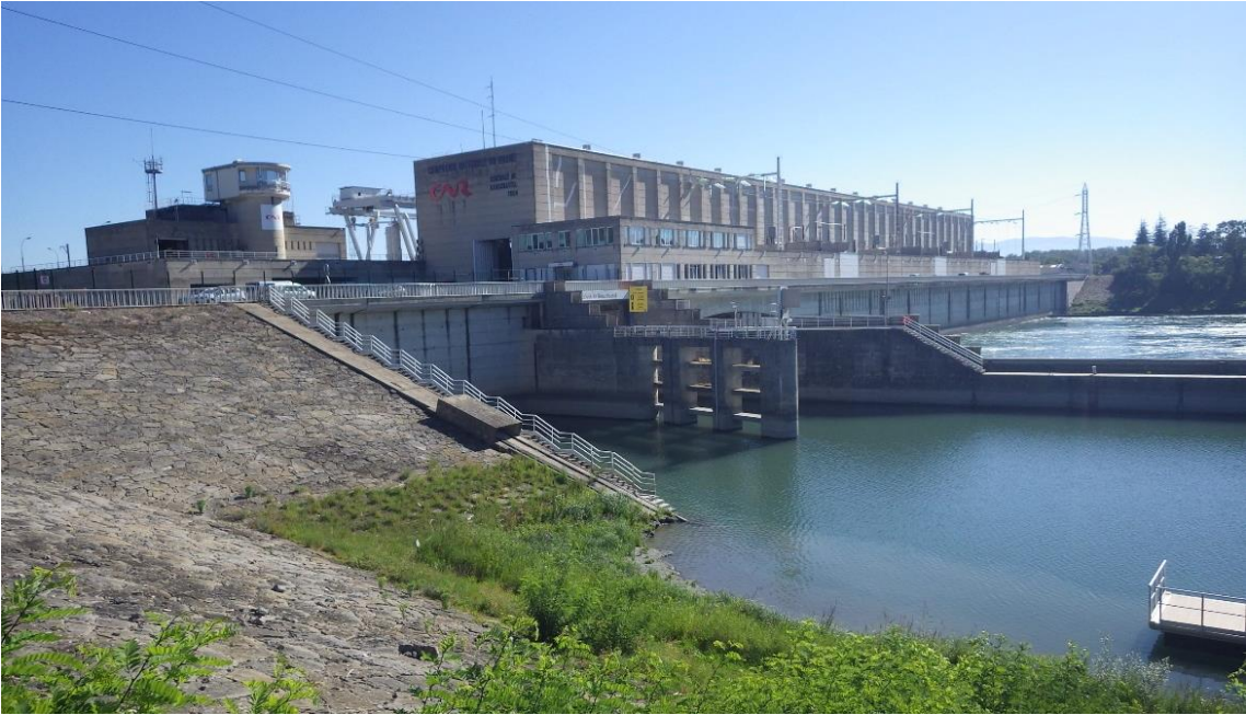
Figure 4 : Photographie de la centrale de Beauchastel depuis la rive droite aval
