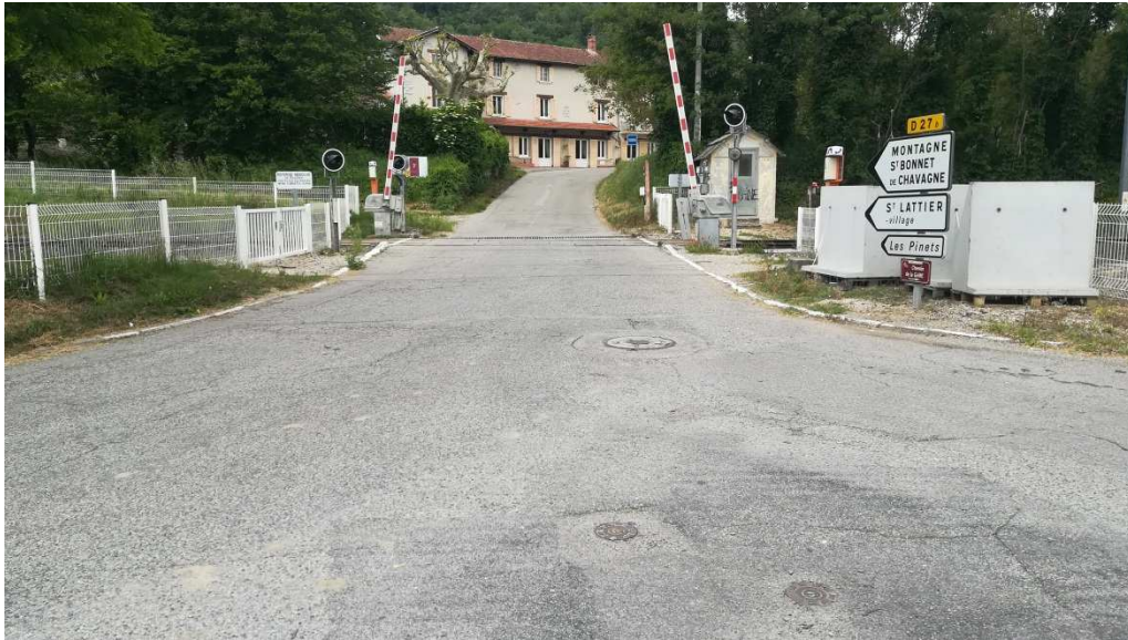
Fig. 9. Passage à niveau au niveau de La Gare
