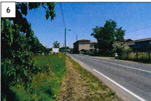
RD 87 en direction de Trévoux
