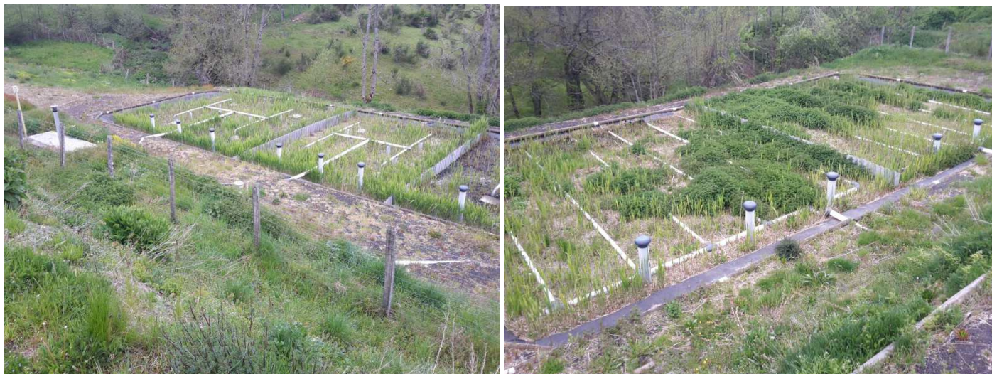
Vue d'ensemble des ouvrages
