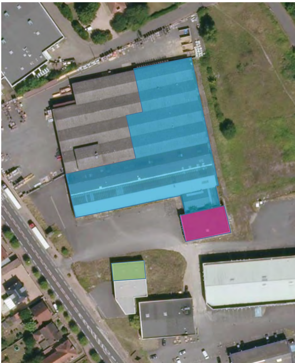
Localisation des différents bâtiments à démolir (extrait Géoportail – vue aérienne à 20 m)
