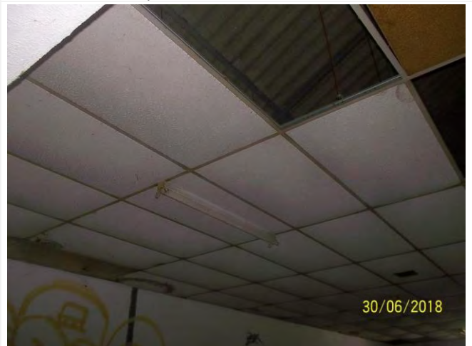
Composant : Faux plafond 14 (N) Locaux Circulation, 4, 5, 6, 7 et 8
