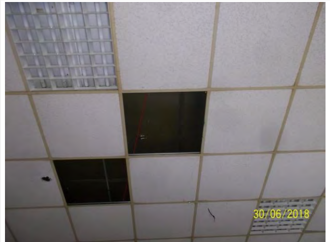
Composant : Faux plafond 12 (N) Plafond Réception PILOTE
