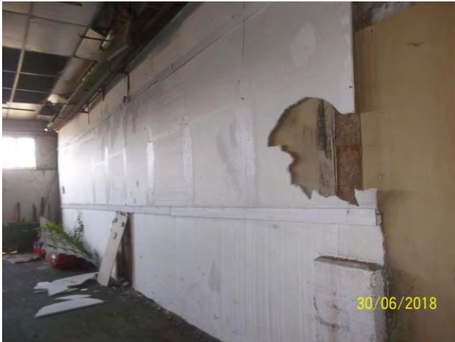
Composant : Calorifugeage 22 (N) Doublage façade avant
