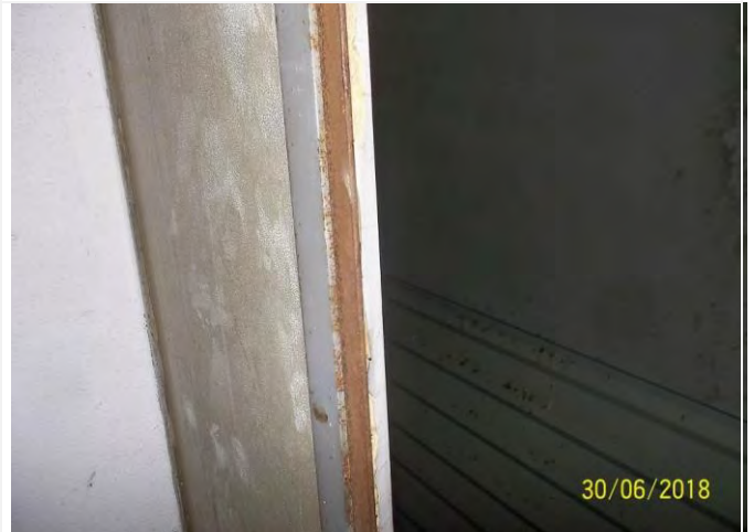
Composant : Joint de vitrage / menuiserie 25 (N) P8-AR-18-LE-079783-01 MASTIC Verrière Métallique CIRCULATION
