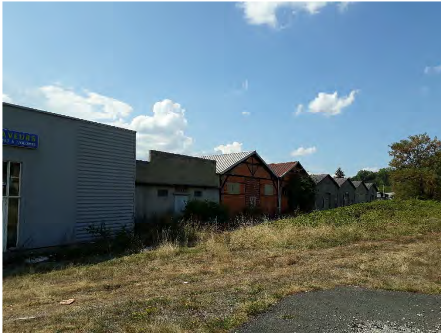
LOCAL TRANSFORMATEUR ET KARTING FACADE OUEST
