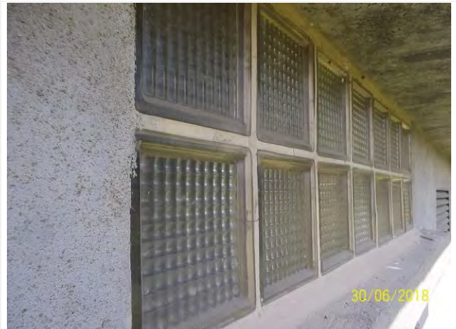
Composant : Peinture ou enduit 51 (N) P28-AR-18-LE-079803-01 ENDUIT PAVE de VERRE FACADE TRANSFO
