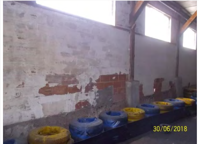
Composant : Peinture ou enduit 17 (N) P3-AR-18-LE-079778-01 ENDUIT sur mur périphérique Brique
