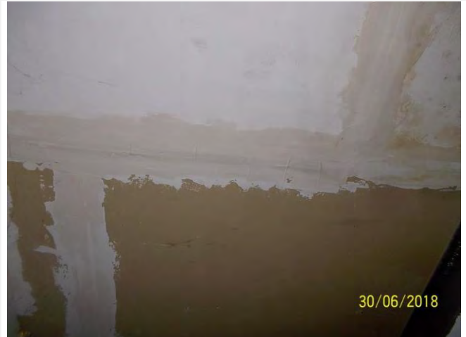
Composant : Peinture ou enduit 33 (N) P13-AR-18-LE-079788-01 ENDUIT BANDE PLACO Plafond WC
