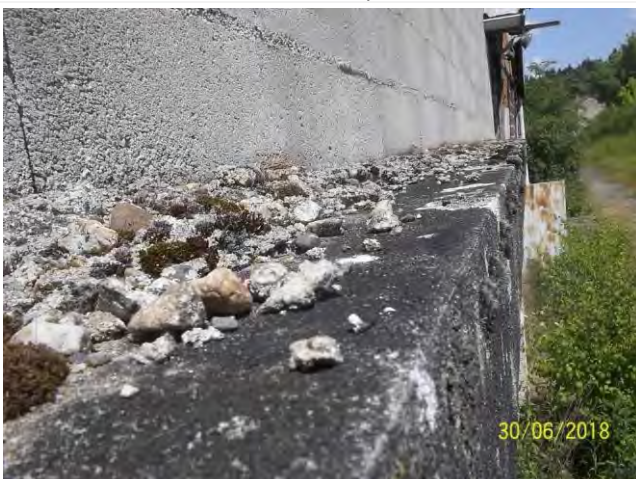
Composant : Peinture ou enduit 50 (N) P27-AR-18-LE-079802-01 ENDUIT MUR EXT TRANSFO
