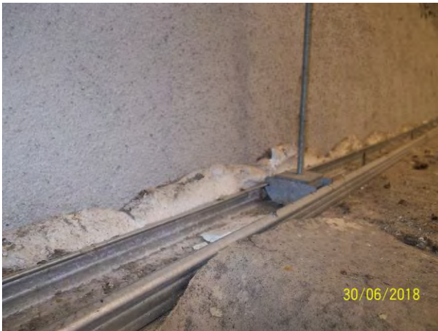
Composant : Peinture ou enduit 31 (N) P11-AR-18-LE-079786-01 ENDUIT BLANC sur Rail Faux-plafond WC
