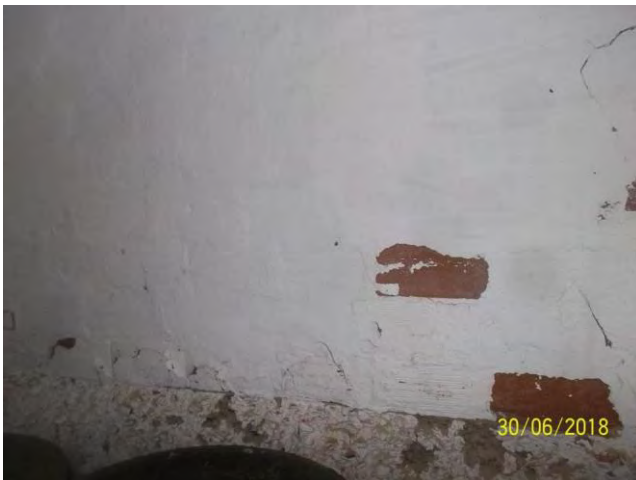
Composant : Peinture ou enduit 15 (N) P1-AR-18-LE-079776-01 ENDUIT Mural Mur Périphérique Brique
