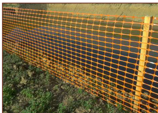
Figure 64 – Exemple de filet de chantier
