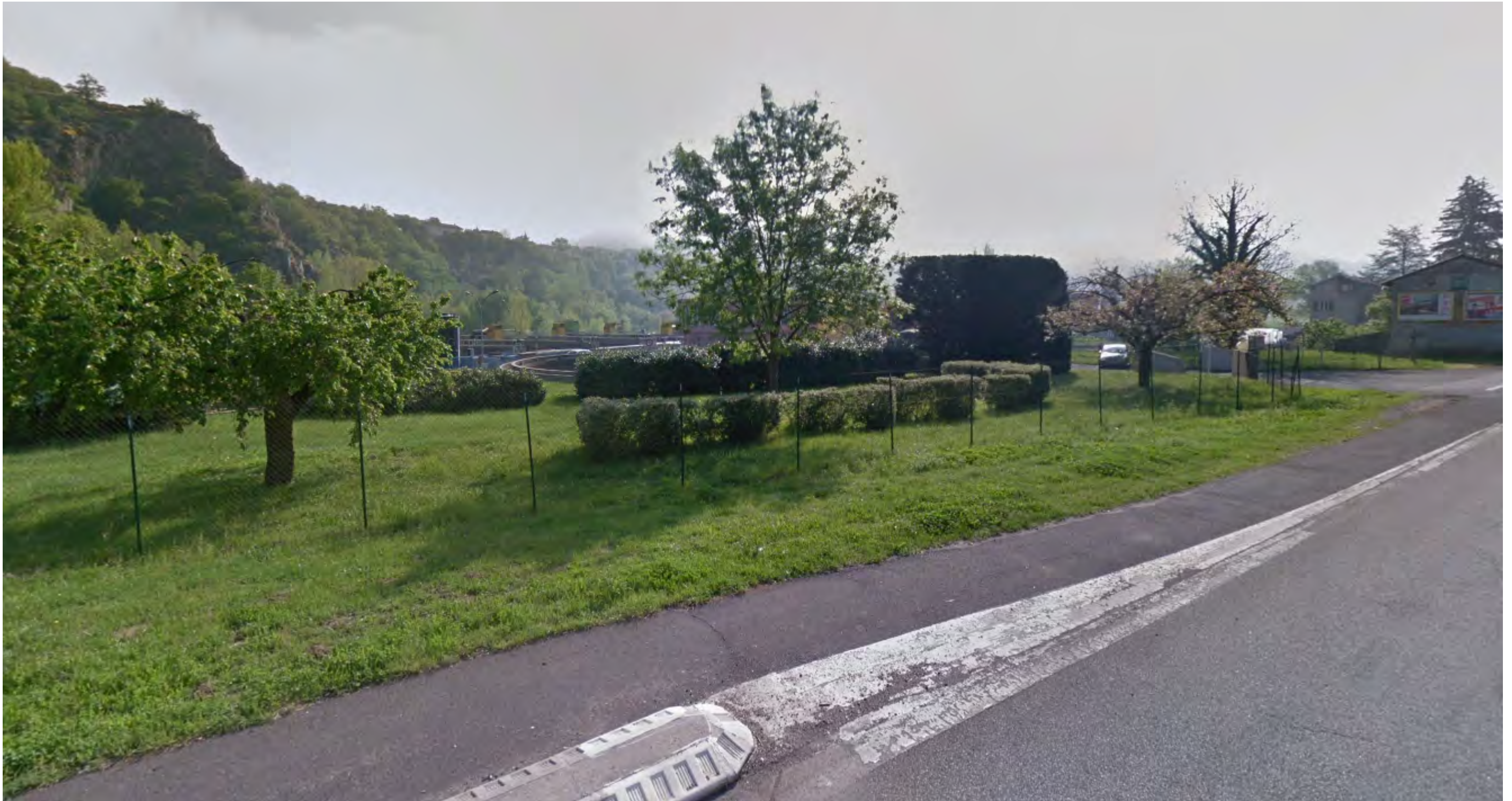
La station d'épuration existante vue depuis le carrefour giratoire
