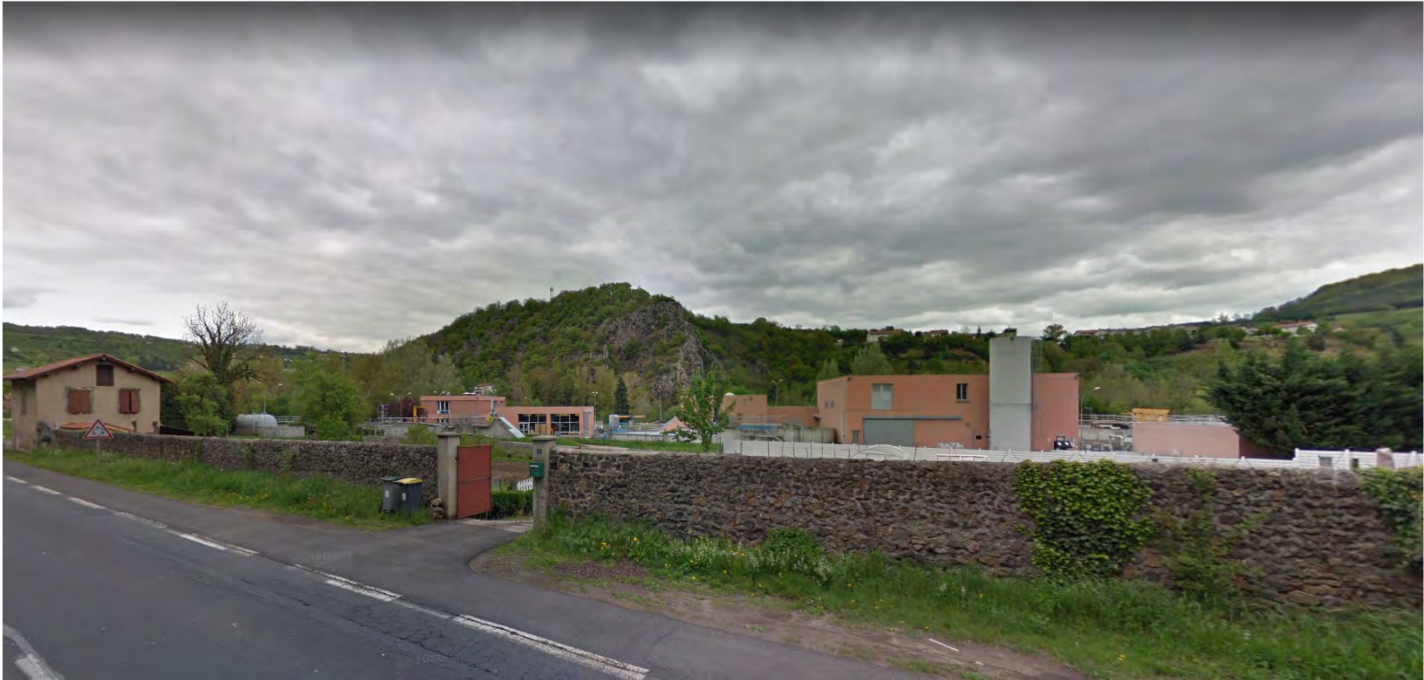
La station d'épuration existante vue depuis la RD 103
