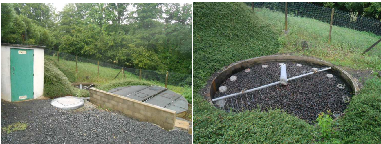
Situation générale de la station
