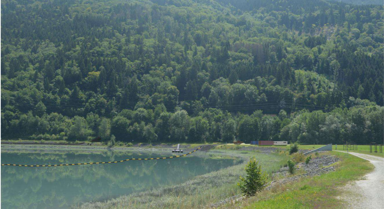
Figure 207 : Photomontage de l'espace de chantier au bord du bassin
