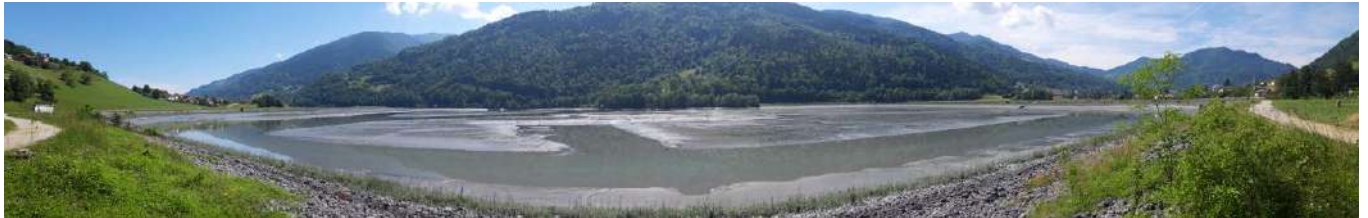
Figure 65 : Vue panoramique du bassin du Flumet a cote basse (494,05 m NGF)
