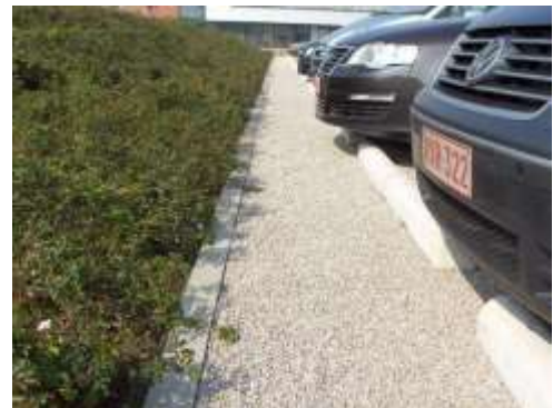
Exemple d'un aménagement de parking en plaques de polypropylène extrudé alvéolaire en forme de nids d'abeilles.
