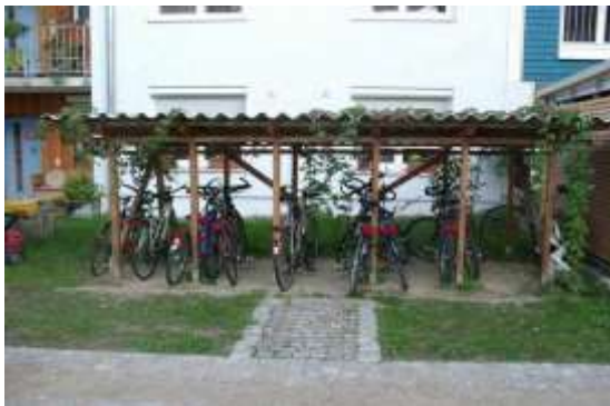
Exemple d'abri vélos permettant seulement la mise à l'abri de la pluie.
