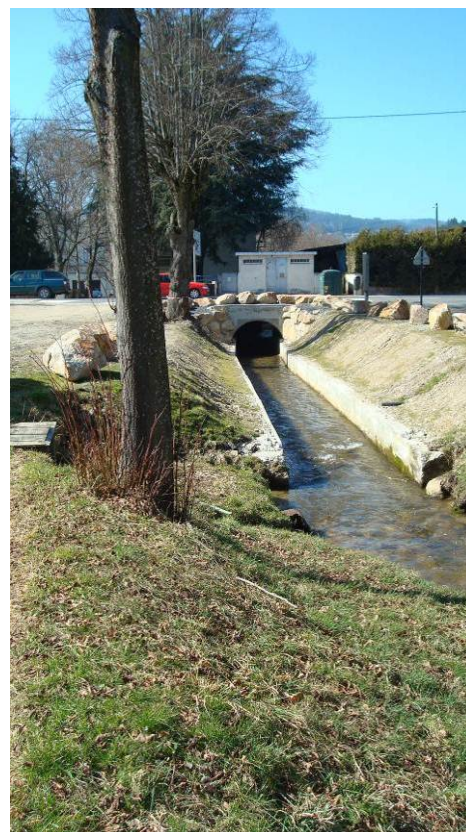
Franchissement RD269 sur le ruisseau de Valeyre – Vue de l'amont
