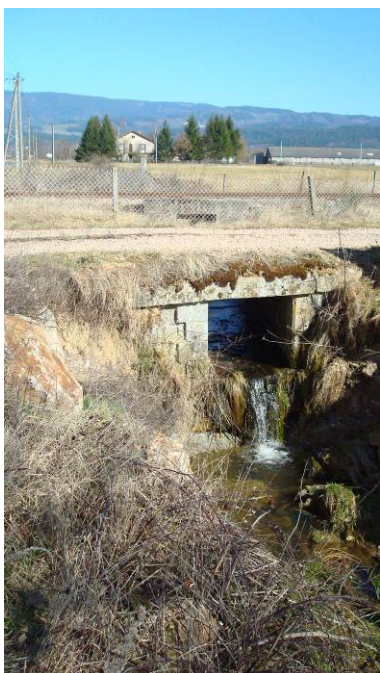
Cadre hydraulique du chemin rural en amont de Visseyre
