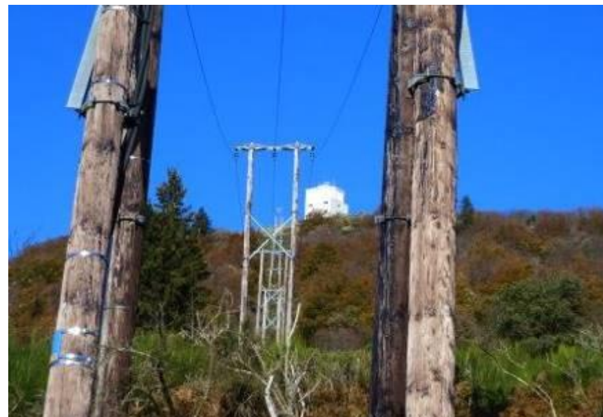
Ligne électrique en voie d'enfouissement
