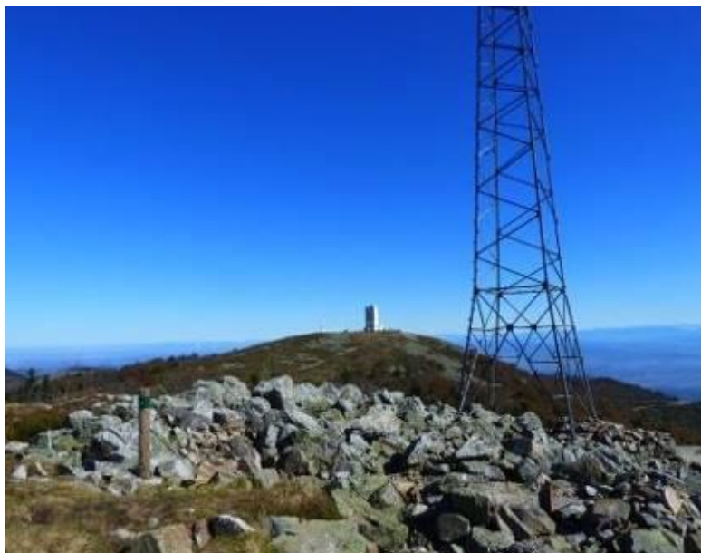
Antenne sur le Crêt de Rachat, qui pourrait être démontée
