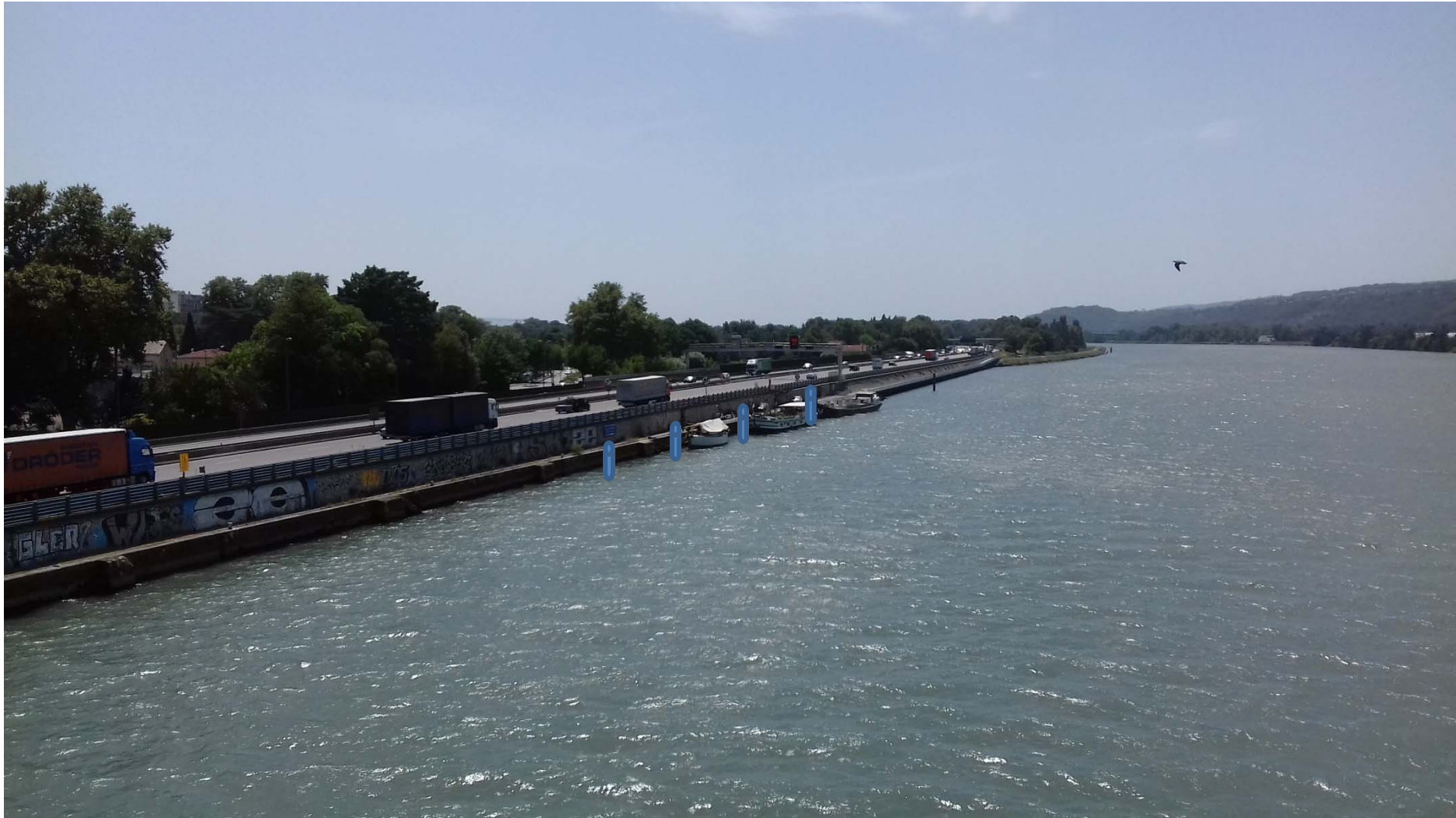
PHOTO 1 (avec emplacement approximatif des pieux)
