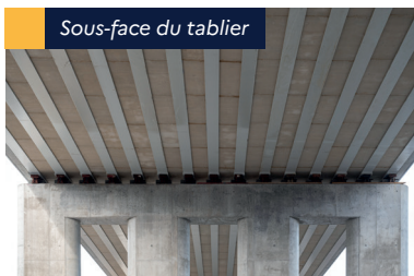
Poutres installées mi-janvier
