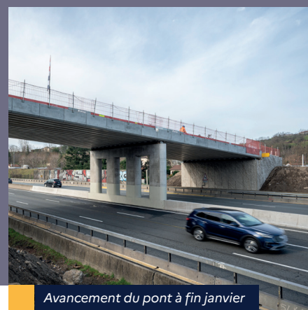
Avancement du pont à mi-janvier
