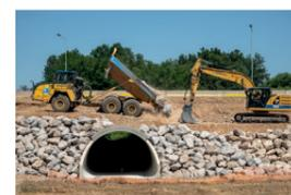
L'élargissement de la bretelle d'insertion vers le Sud a conduit à agrandir un ouvrage hydraulique existant, qui sert de décharge du cours d'eau de la Barberolle en cas de crue. Un ouvrage de maçonnerie supplémentaire a été ajouté à l'existant et des enrochements ont été mis en place pour assurer la stabilité du talus.
