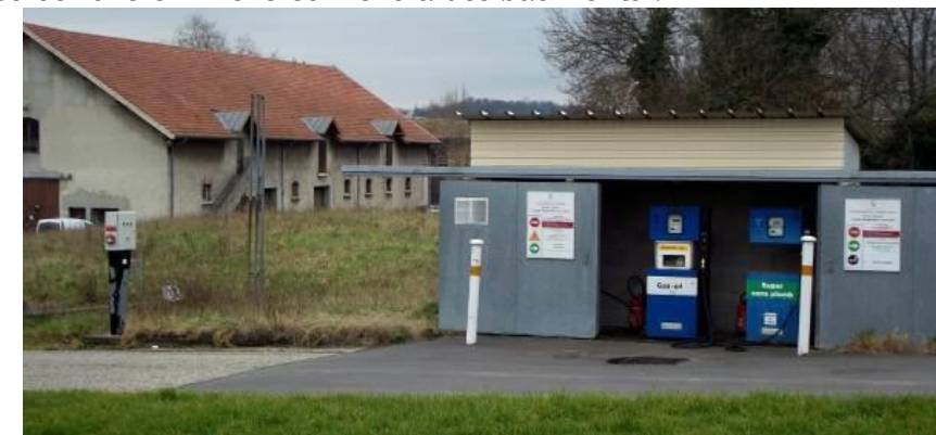
Pompes à gasoil et essence des hôpitaux de Lyon Sud
