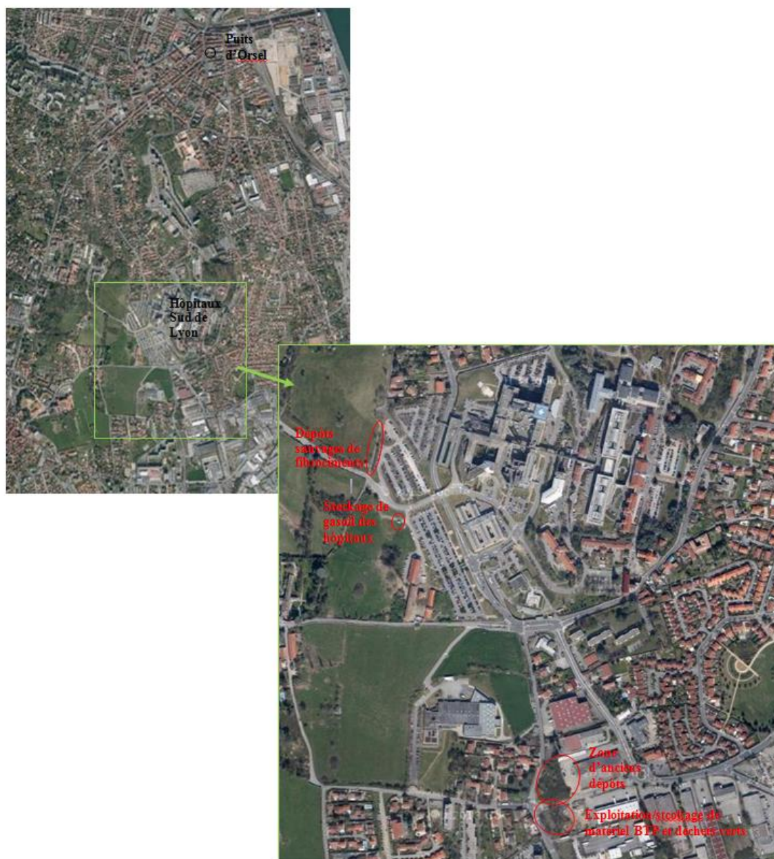
Localisation d'anciens remblais et d'anciennes zones de dépôt à faible risque de contamination
