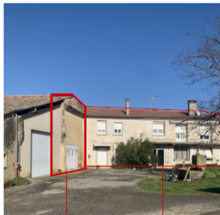
ANNEXE A RENOVER
