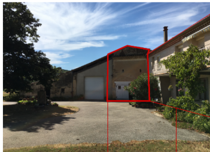
ANNEXE A RENOVER
