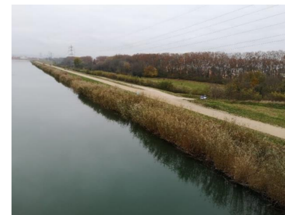
Figure 4 : Zone N hors des emprises projet en bordure du canal de Jonage – secteur de la Soie (© Artelia, 2021)
